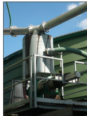
Substrat faststofs udskiller
