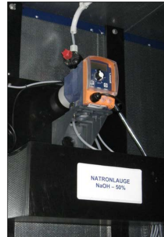
Natriumhydroxid doseringspumpe
