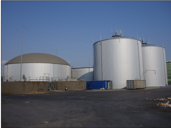
De 2 primære rustfrie stål rådnetanke (til højre) & den sekundære rådnetank med gaslager (bagerst til venstre)
