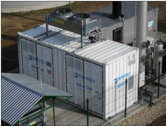
Biogas opgraderingsenhed i ISO stål container
